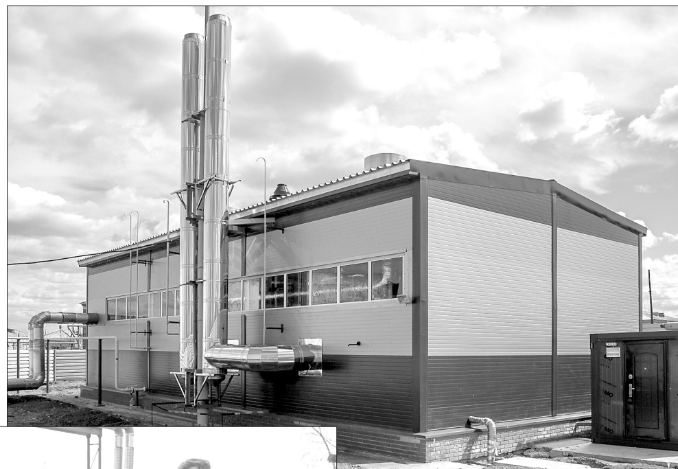
Новая автономная газовая котельная обслуживает 59 жилых домов.
